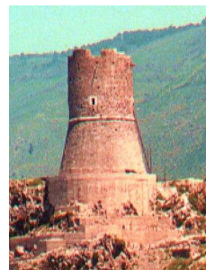
Torre di avvistamento
